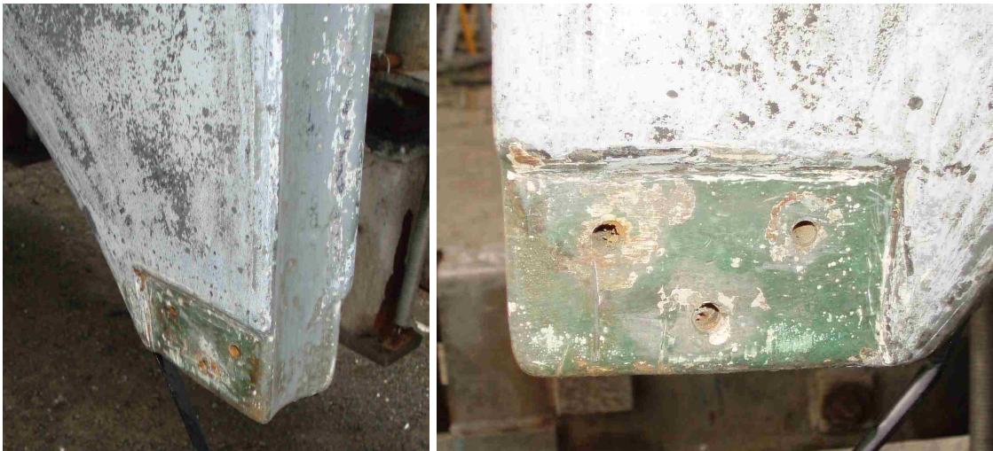
Grattage, ponçage et vérification de l'état des surfaces, reprise si nécessaire
