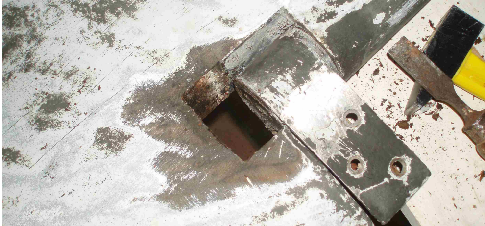
Une fois la cale retirée, l'espace nécessaire au retrait de la patte est disponible
